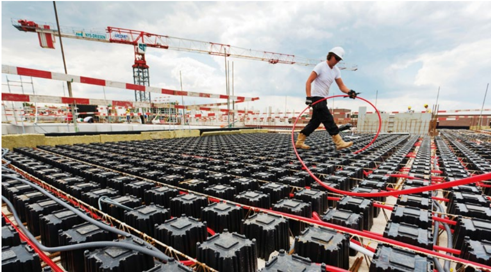
Betonkernactivering maakt een intelligent energiebeheer mogelijk in een gebouw - AirDeck. © Bouwteam Houben
