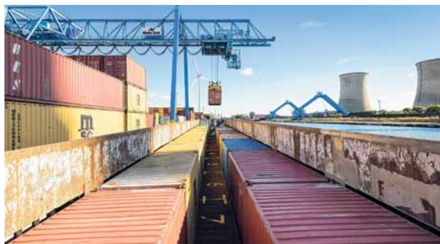
Verhoging bruggen voor meer containervervoer
